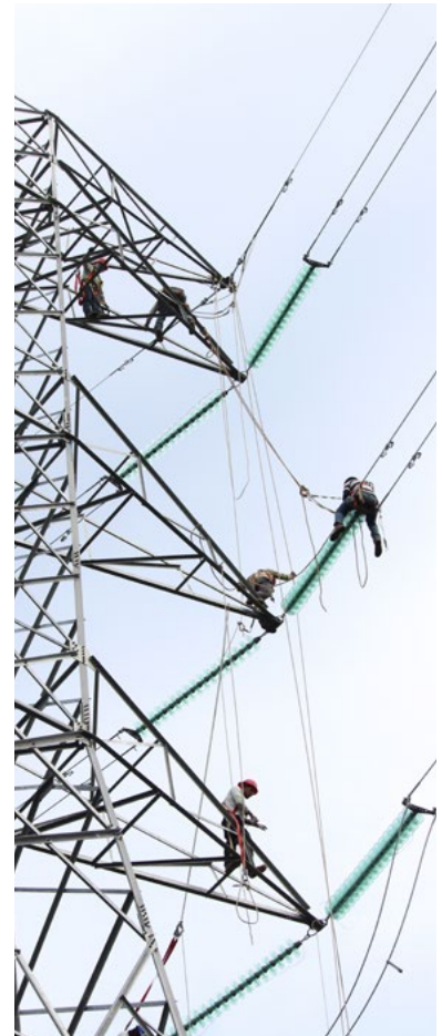
Trabajos en líneas de transmisión
