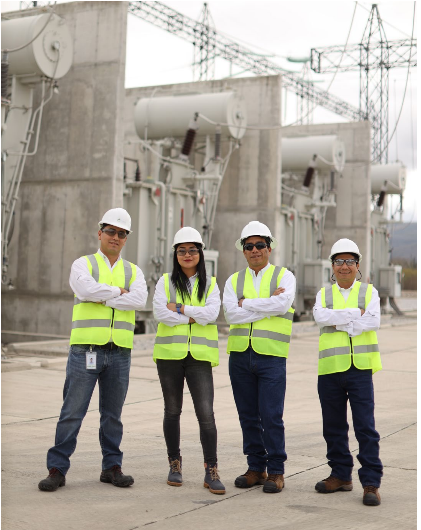
Colaboradores de Trecca en Subestación San Agustín
