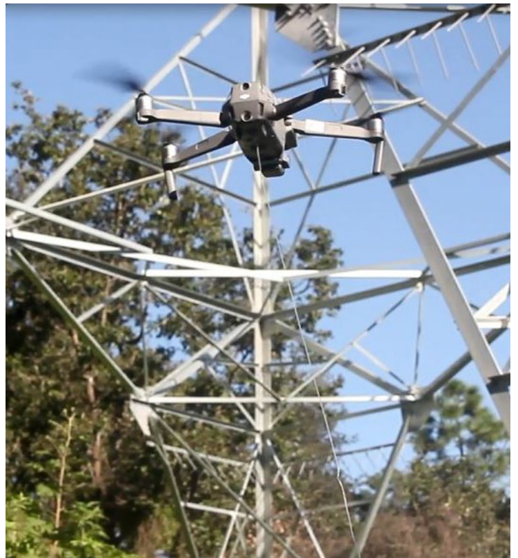
Tendido de Línea de Transmisión utilizando tecnología de dron
