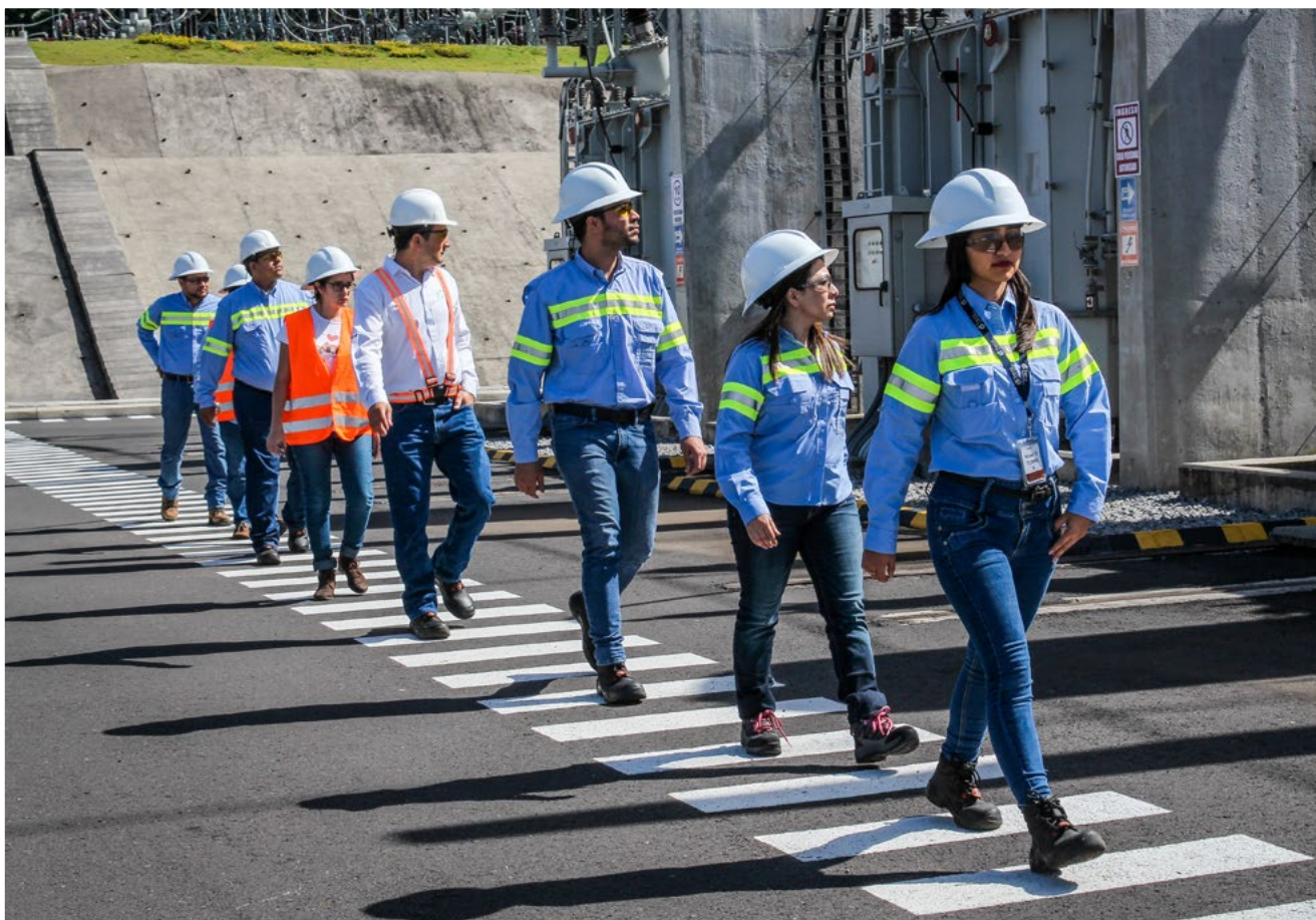
Colaboradores en Subestación Palestina
