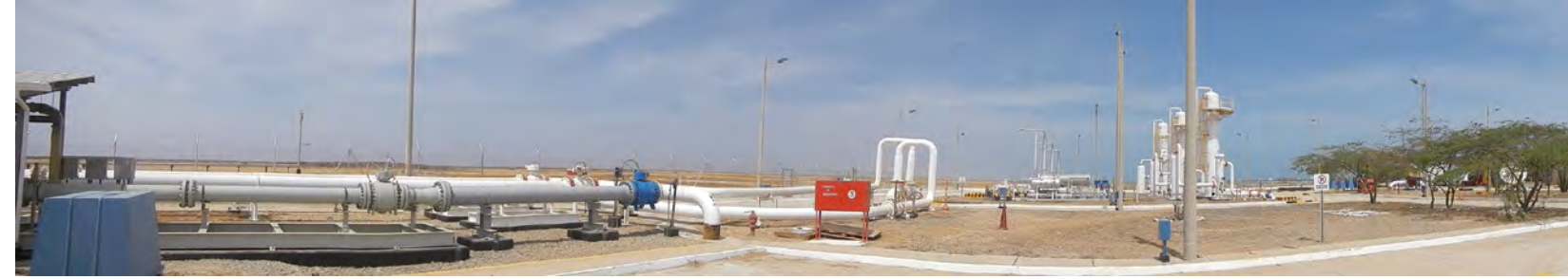
INFRAESTRUCTURA TGI HATÓNUEVO, LA GUAJIRA
