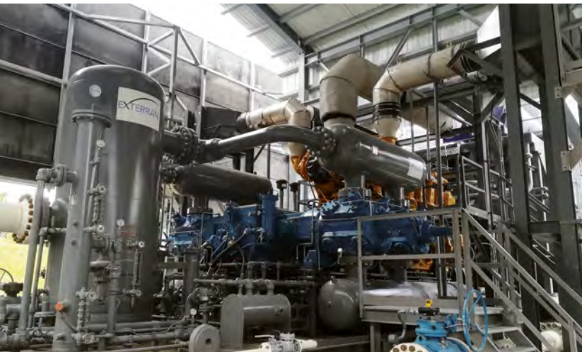
INFRAESTRUCTURA TGI PUENTE GUILLERMO, SANTANDER
